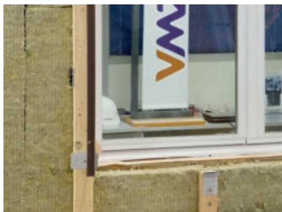
2 Pose des cornières au ras des clips
