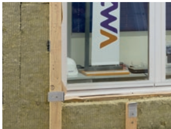
1 Pose des clips universels
