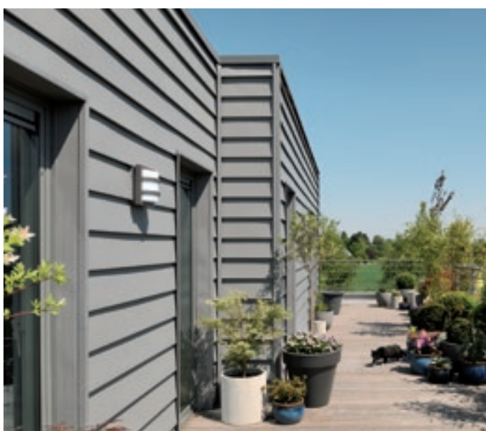
Logements, Braine-L'Alleud (Belgique) - Architecte : CERAU Architecture - Entreprise : S.M.C.O. Photographe : Georges De Kinder
