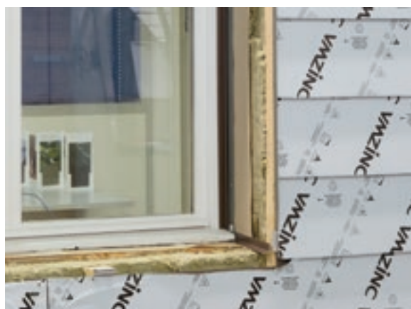
4 Pose des pinces de réglage et cornières d'angle
